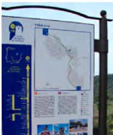
Paneles esmaltados, con el contenido gráfico de la señal en serigrafía y vinilo y con una lámina protectora transparente o un lacado de protección.
